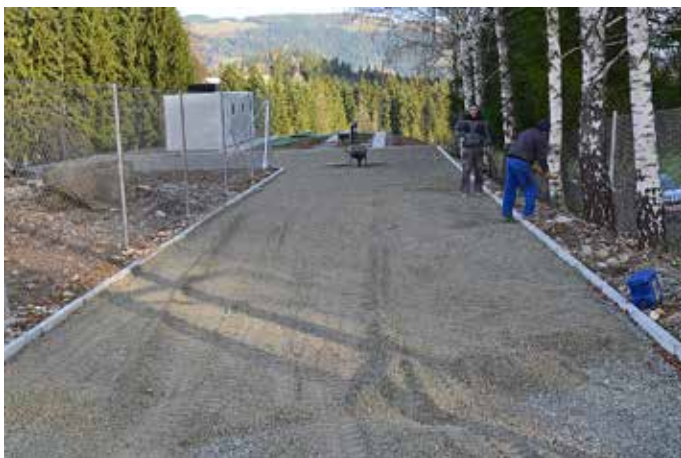
Čistilna naprava Josipdol v izgradnji
