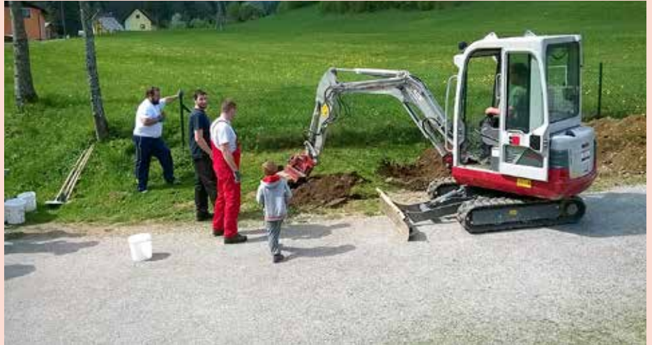
Delovna akcija izkop in betoniranje jaška za postavitev majskega drevesa in nosilcev zastav
