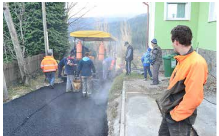
Kratek odsek asfalta, a prahu ne bo več
