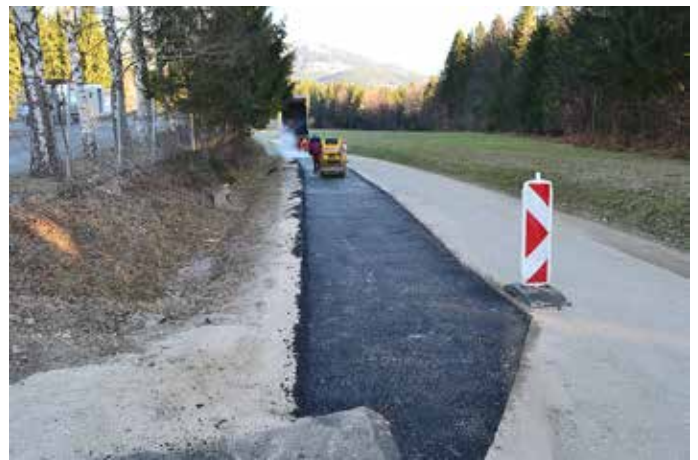
Popravilo dotrajanega asfalta
